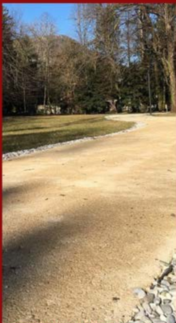
Pavimento in terra stabilizzata drenante e bordatura in ghiaia
