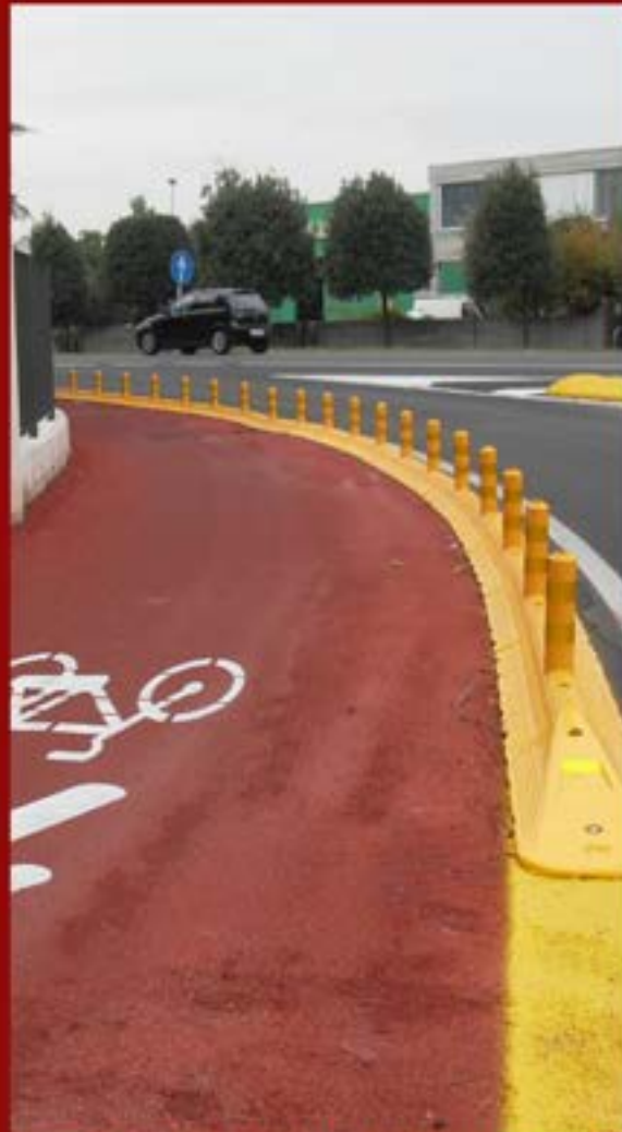
Pista ciclabile asfaltata di rosso con protezione dalle auto in circolazione
