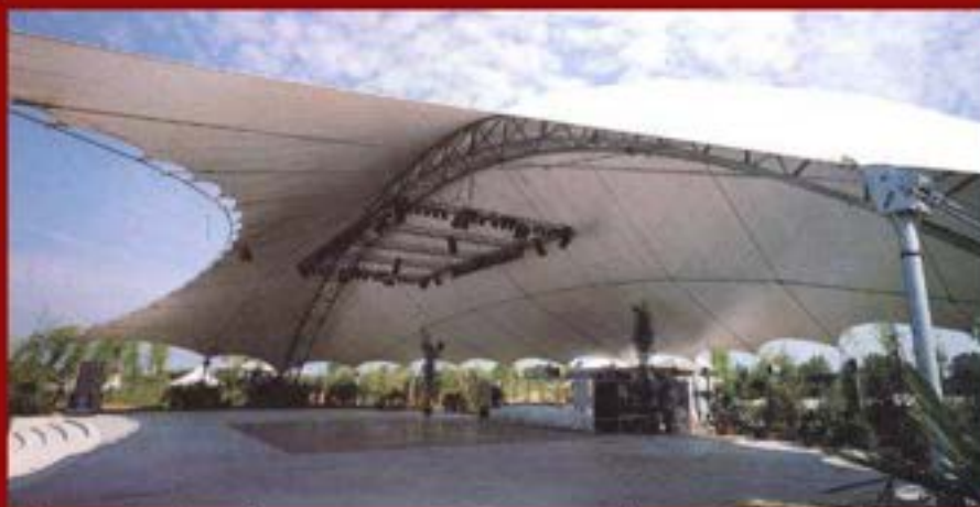
Tensostruttura fissa, ancorata a terra mediante trave reticolare curva e cavi in acciaio con telo in PVC di copertura
