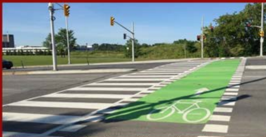
Attraversamento pedonale accostato a quello ciclabile colorato con resine ad alta resistenza e tenuta
