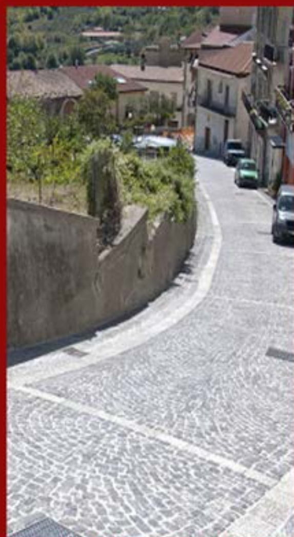
Pavimento a cubotti di porfido posato ad archi con deflusso laterale in pietra Trani
