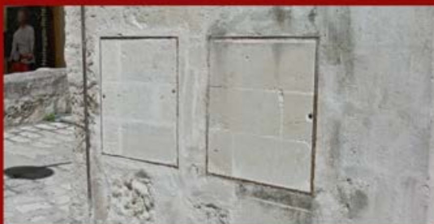
Contatori utenze, incassati a muro con finitura a facciavista
