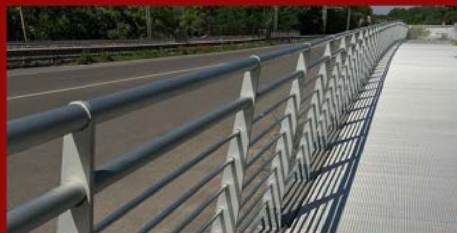
Parapetto continuo in acciaio inox
