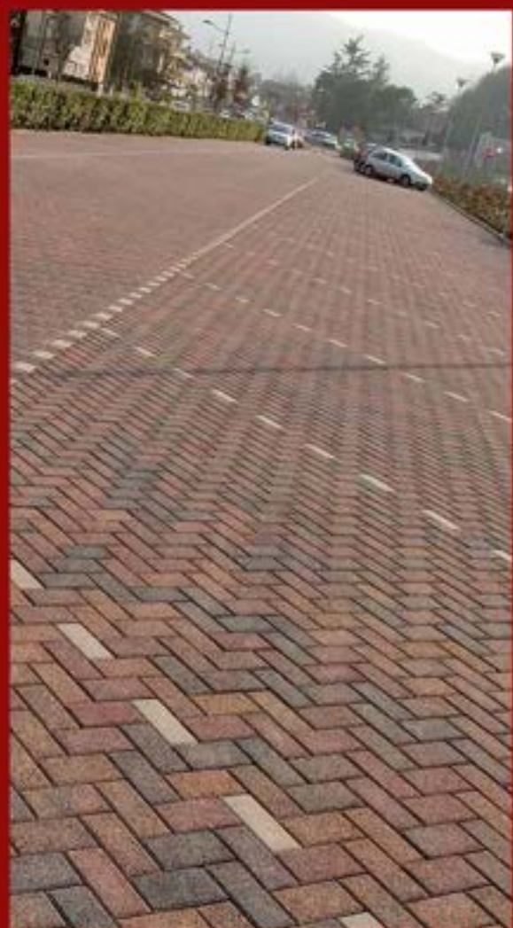
Parcheggio realizzato con blocchetti di cls con diversa colorazione
