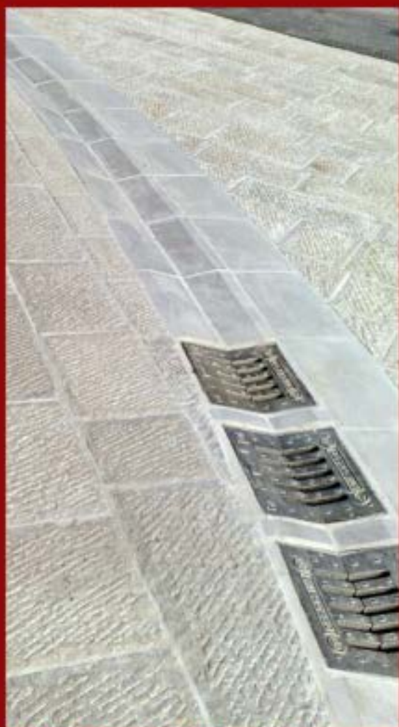
Caditoia in ghisa all'interno della canalina centrale di raccolta in pietra di Trani
