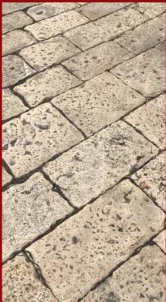
Pavimento a basole in pietra di Trani tagliato e bocciardato a mano
