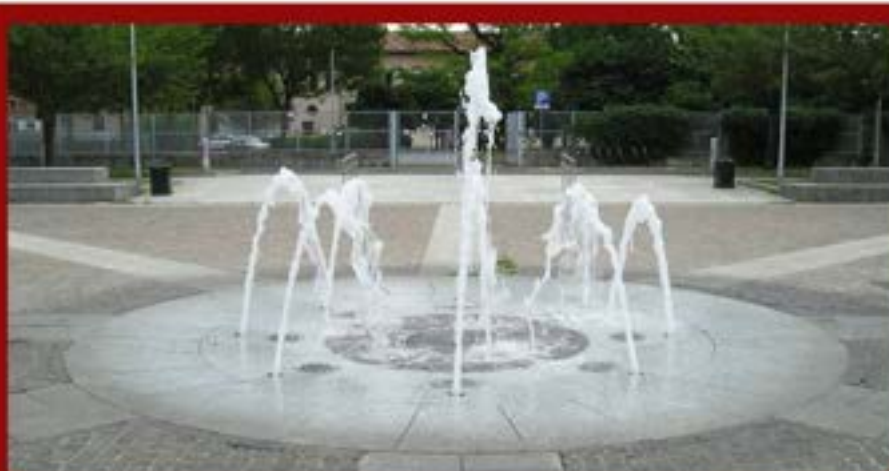
Fontana circolare a raso a getti d'acqua con illuminazione notturna
