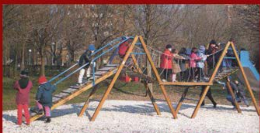
Attrezzo "Ponte sospeso" realizzato in legno di pino trattato per esterno con giunti in metallo zincato, catene e gomma
