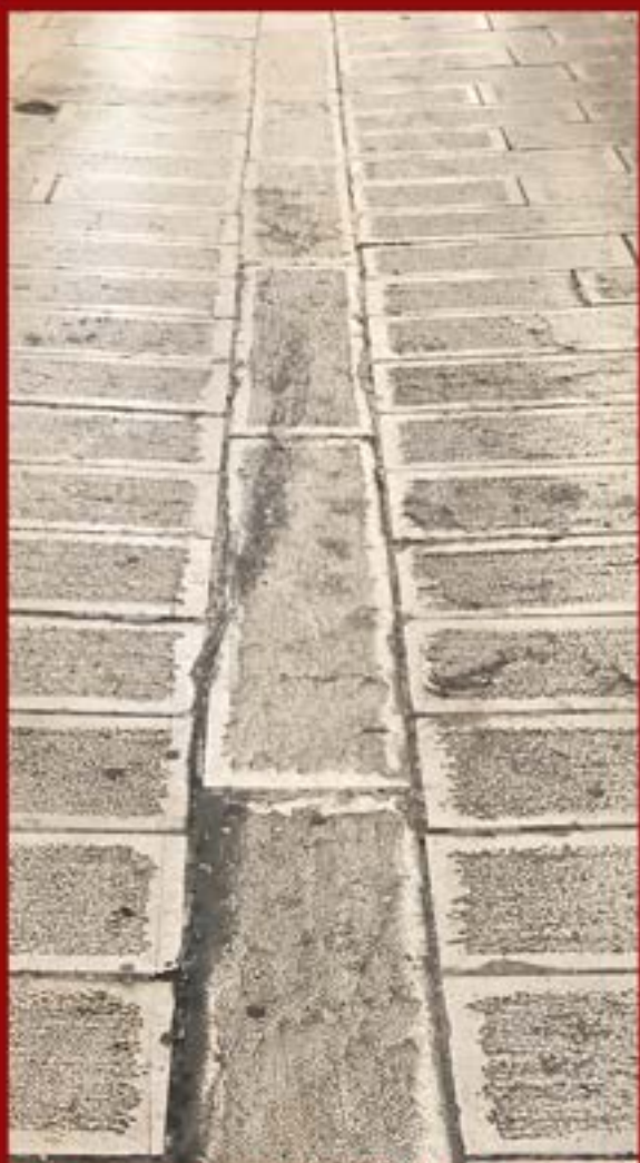
Pavimento a basole squadrate posato a correre con deflusso centrale
