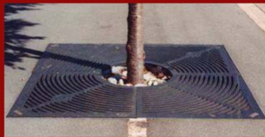
Protezione per albero in ghisa quadrato incassato nel pavimento
