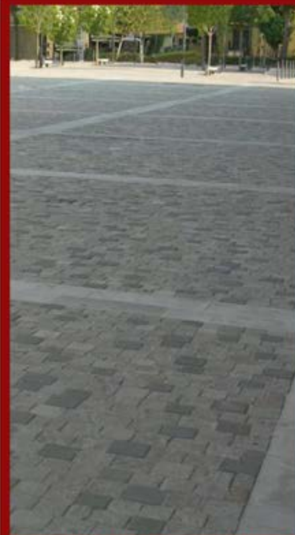
Pavimento a quadroni composto da blocchetti in cls con sfumature differenti
