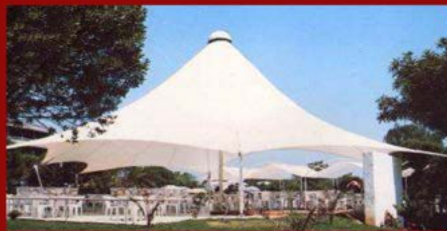
Tensostruttura mobile, ancorata a terra mediante palo e cavi in acciaio con telo in PVC di copertura
