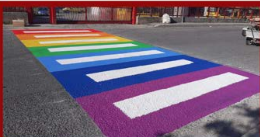
Strisce pedonali colorate per ingresso in edifici scolastici
