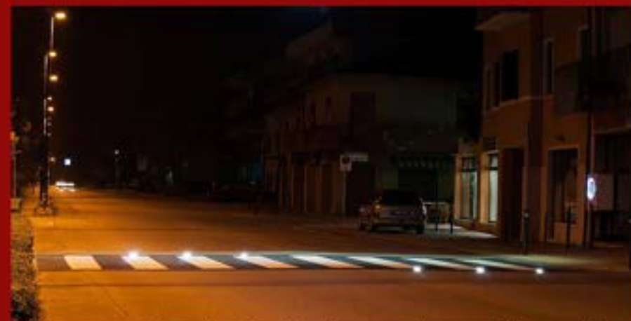
Attraversamento pedonale colorato con resine e catarifrangenti incassati nella sede stradale
