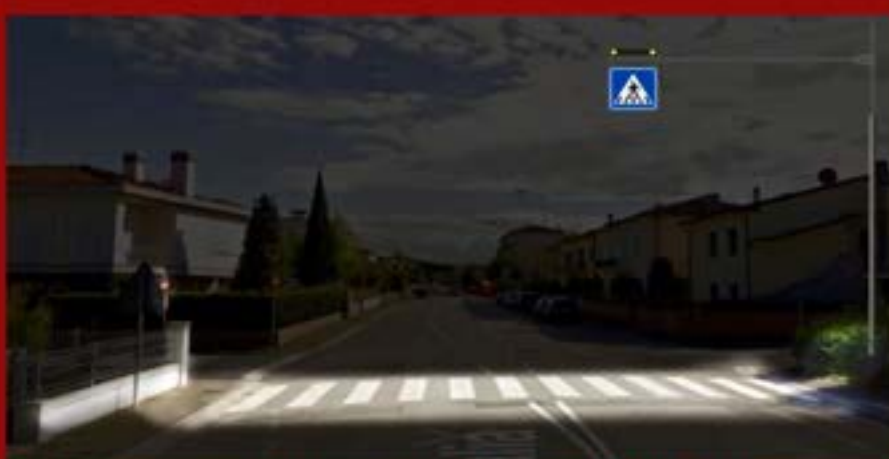
Attraversamento pedonale colorato con resine ed illuminato dall'alto per mezzo di pannello di segnalazione
