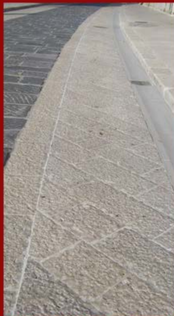
Pavimento a basole miste con canalina di raccolta laterale in pietra di Trani
