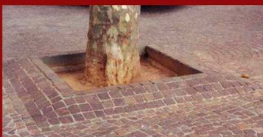
Protezione per albero ricavata dalla elevazione del pavimento
