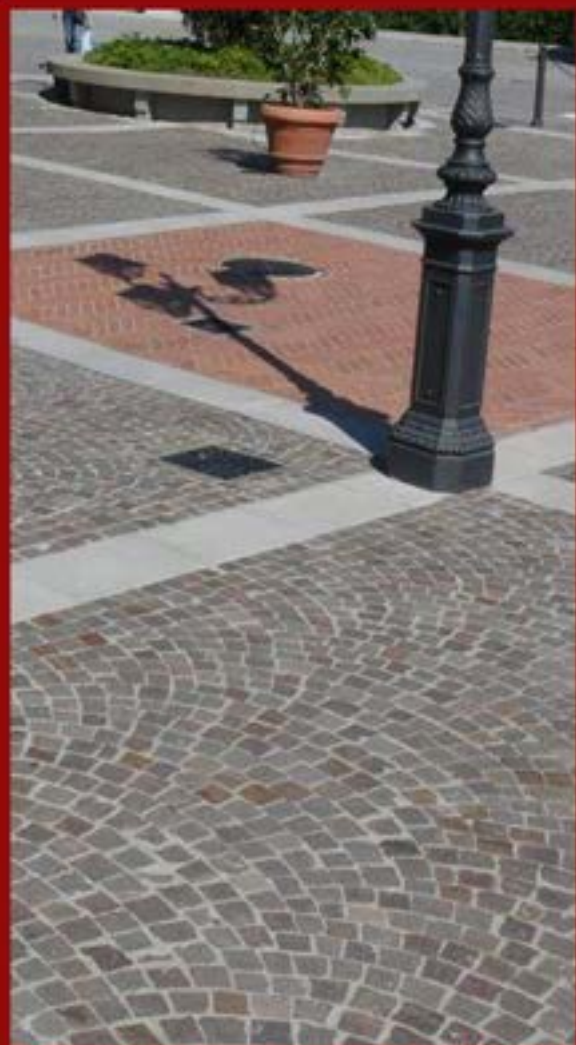
Pavimento misto in porfido e cotto con posa ad archi e a spina di pesce
