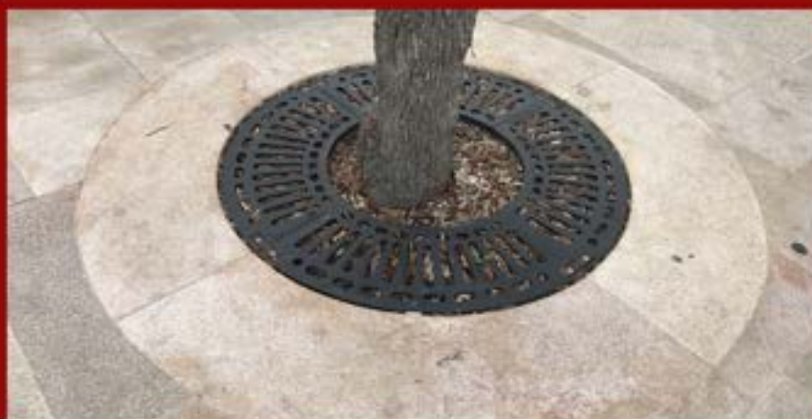
Protezione per albero in ghisa tondo incassato nel pavimento
