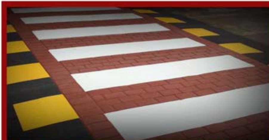
Attraversamento pedonale rialzato, realizzato in bitume stampato e colorato con resine
