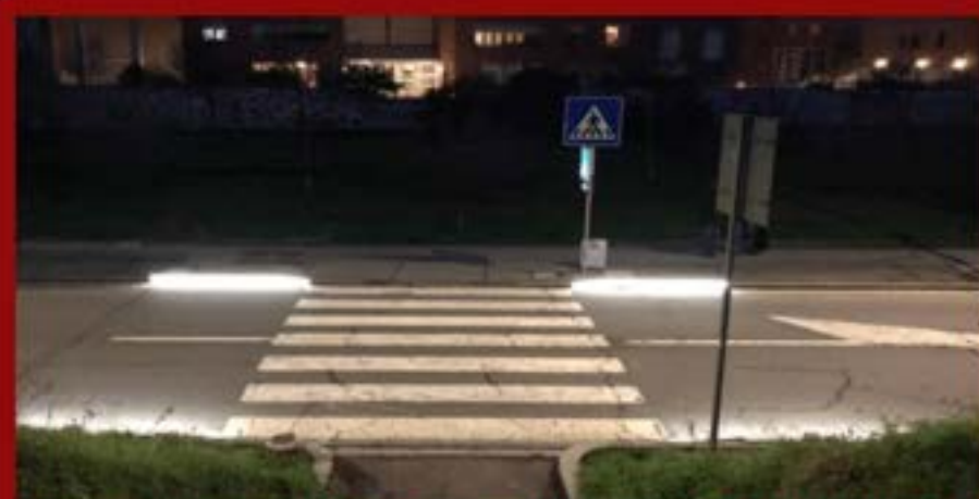
Attraversamento pedonale colorato con resine ed illuminato dal basso per mezzo di strisce led incassate nel marciapiede
