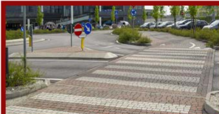
Attraversamento pedonale realizzato con blocchetti di Porfido rosso e Biancone di Trani
