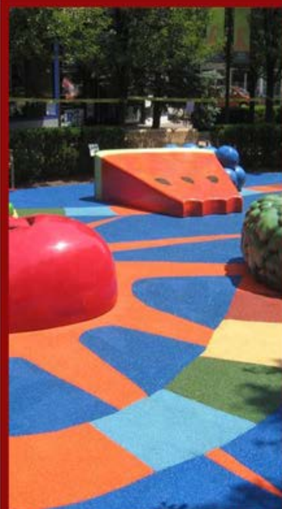
Pavimento anti-trauma in gomma colata e gettato in opera
