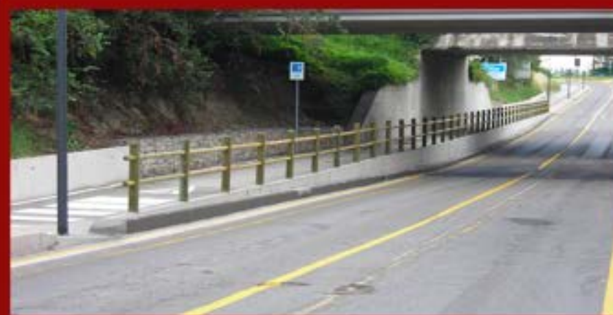
Transenne in legno trattato per esterno
