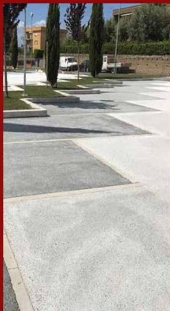
Parcheggio realizzato con stabilizzato drenante con diversa colorazione
