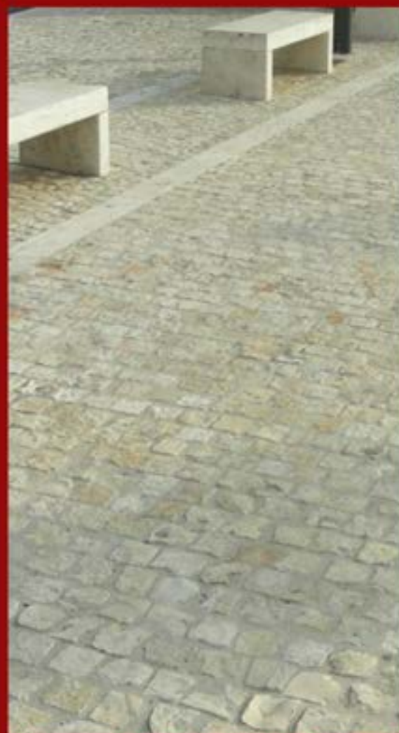
Pavimento a cubotti in pietra di Trani tagliati a mano e posati a correre
