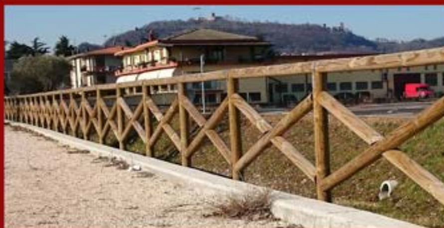
Parapetto continuo in legno con travi incrociate
